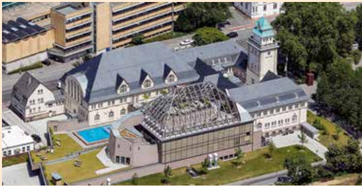
Aufwändig wurde auch das Dach des alten Jugendstil-Gebäudes saniert.
