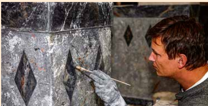
Restaurator beim malen der Marmorierung auf Stucco lustro
